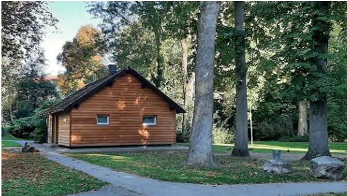
Abbildung 6: Renovierte Hütte im Hammerpark
