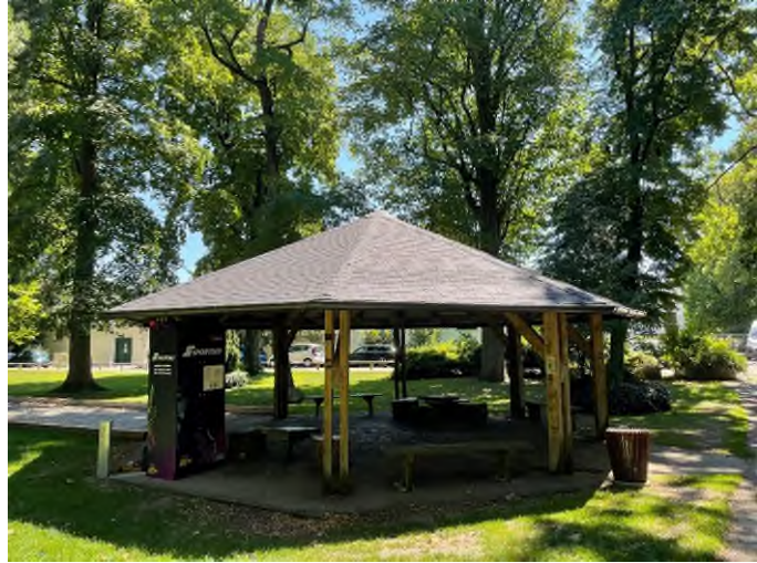
Abbildung 11: Pavillon nach der Sanierung
