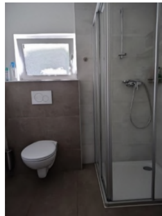
Abbildung 8: Sanitäranlage Hütte Hammerpark
