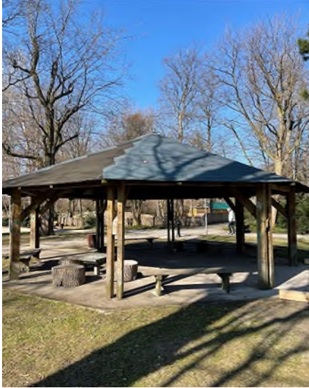
Abbildung 10: Pavillon vor der Sanierung
