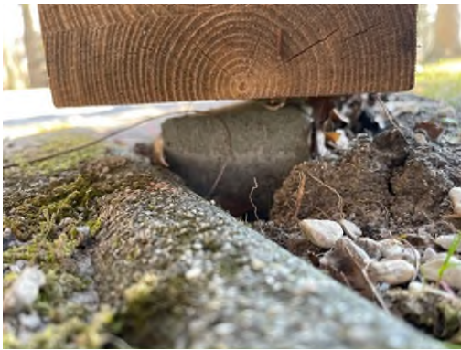
Abbildung 5: Befestigung Holzumrandung Boulebahn
