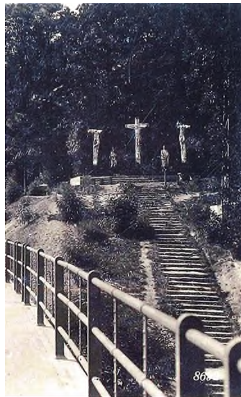
Abbildung 3: Ansicht Treppenanlage nach 1936
