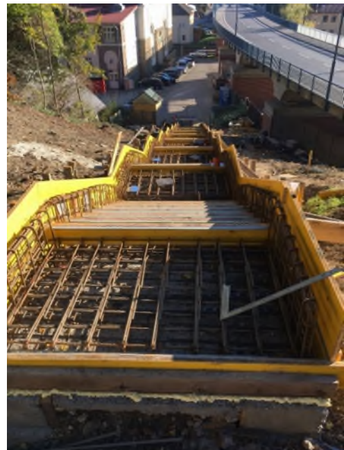
Abbildung 6: Treppenanlage geschalt
